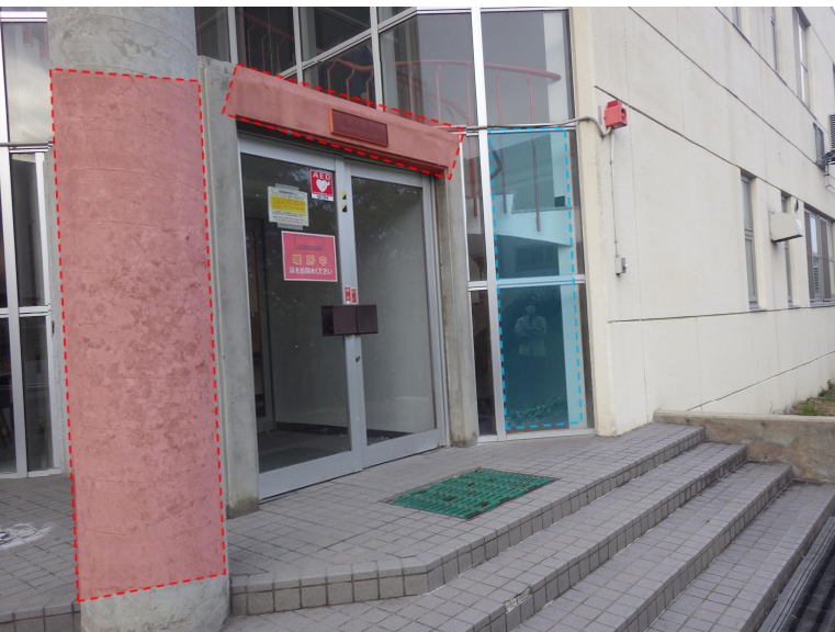
建物玄関(出入口上部・窓・柱)
