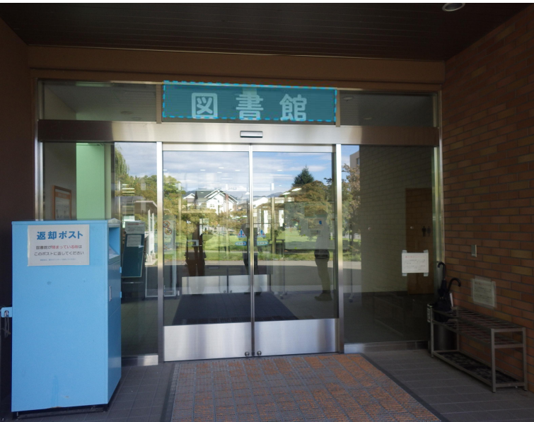
建物玄関 (出入口上部)
