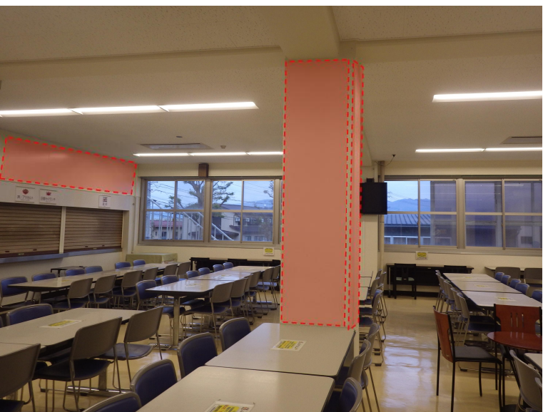
提供台上部(食堂北側)・柱(食堂中央)
